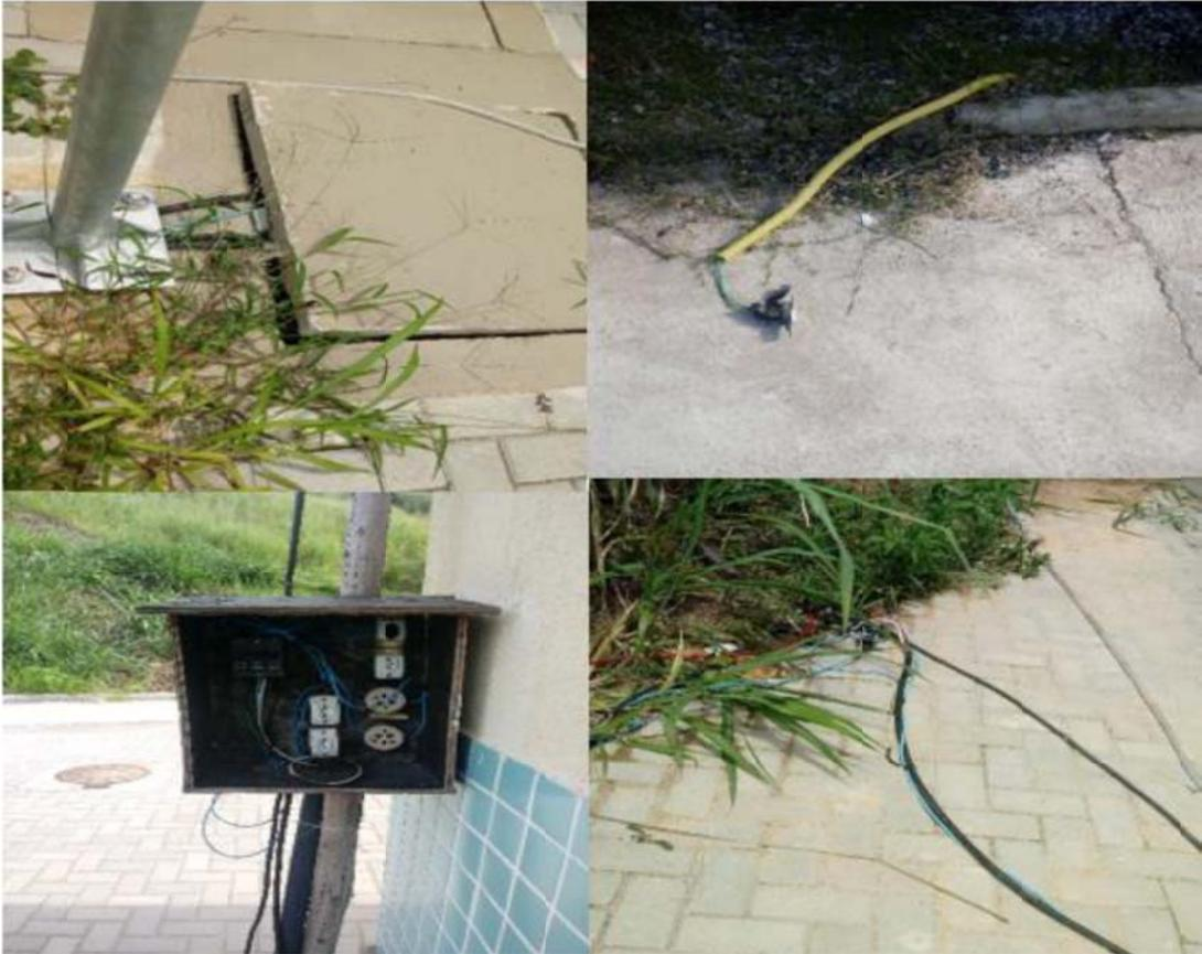
Figura 1 Fios expostos sem proteção nas áreas externas do PESC
