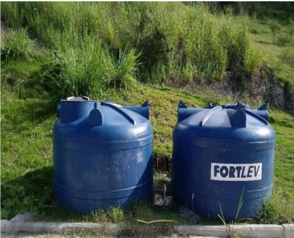
Figura 2 Caixa d'água sem lacre de proteção nas tampas
